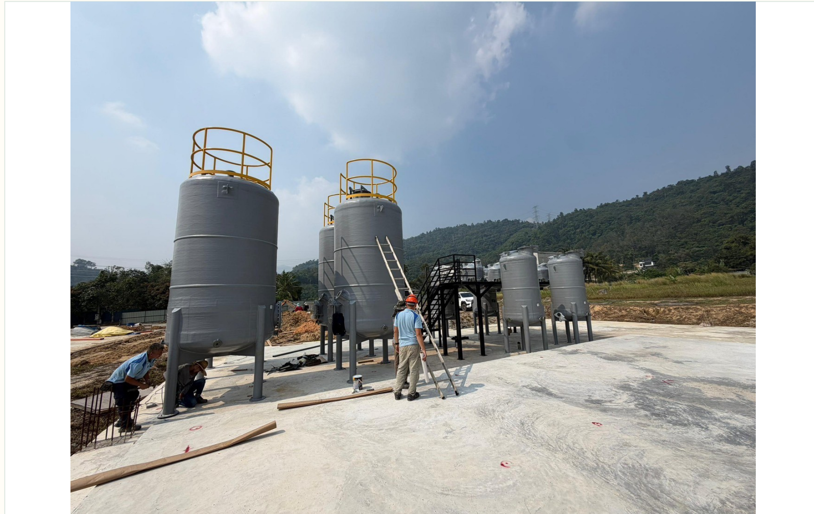
マレーシアでのタンク設置工事 | 提供写真
