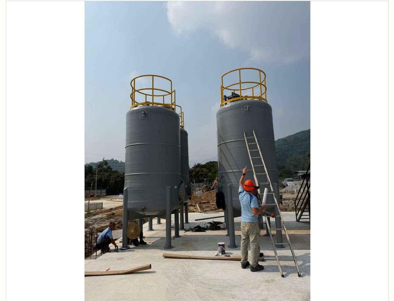
同じ建設現場の別角度 | 提供写真
